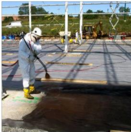
Photographie 1 - Mise en place d'une membrane en spray (crédit photo CETCO).
