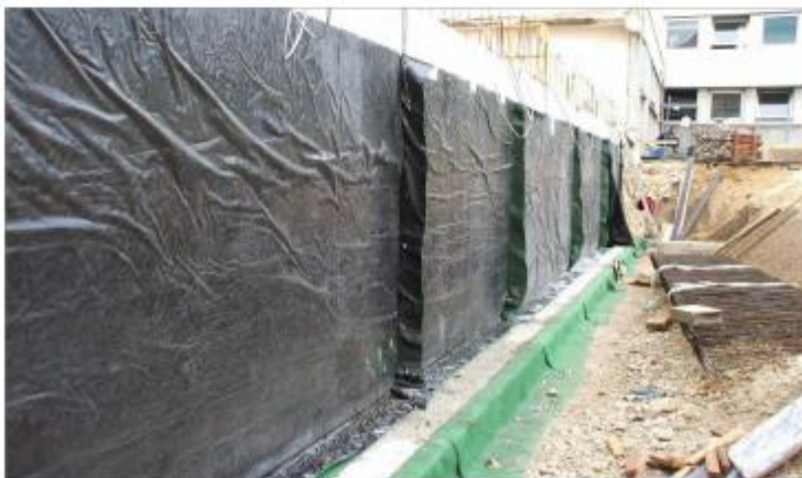
Photographie 2 - Exemple de mise en œuvre d'une membrane le long d'une paroi moulée verticale. Source et crédit photo : Documentation technique et commerciale, société CETCO.
